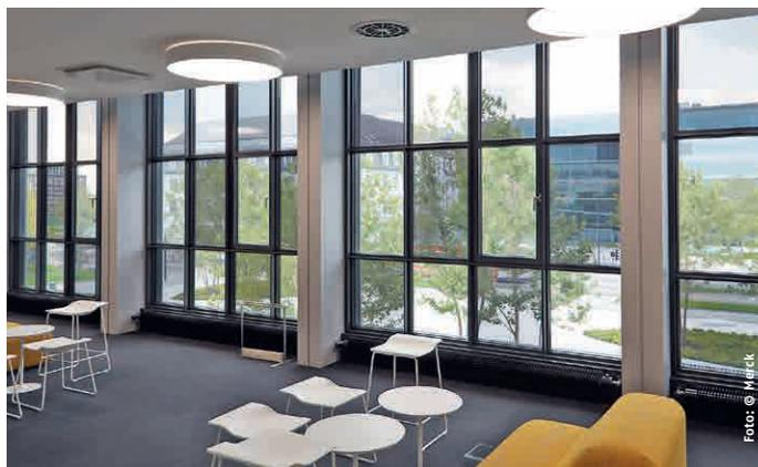
Das dynamische Flüssigkristallfenster eyrise s350 ermöglicht Verschattung auf Knopfdruck, im Foto zu Demonstrationszwecken im Schachbrettmuster.
