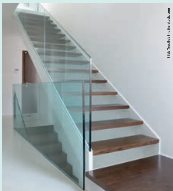
Beispiel für eine kleinere Anwendung mit Trosifol ES mit Schubverbund
