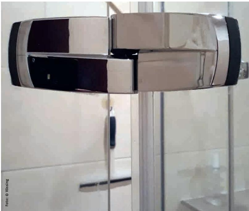
Der Luftspalt an der Duschtür ist gut zu erkennen. Die Finger einer Hand passen locker hindurch. Das ändert sich schlagartig, wenn die Tür geschlossen wird. Die wenigen Millimeter, die die Spritzschutzdichtung nachgibt, reichen dann nicht aus, um Quetschungen zu verhindern. Besonders tückisch sind solche Spalte an den Nebenschließkanten von Türen in Räumlichkeiten, die von Kindern genutzt werden. Kindliche Unwissenheit oder Unachtsamkeit können hier schnell zum Unfall führen.
