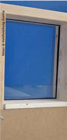
**Bild 4:** Vertikal-Schiebefenster, bei dem ausschließlich die Vakuumscheibe (ohne Flügelrahmen) bewegt wird, in geöffnetem Zustand.
