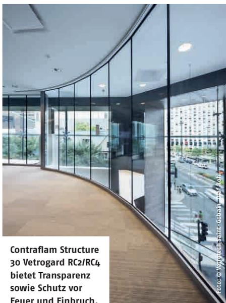
**Contraflam Structure 30 Vetrogard RC2/RC4 bietet Transparenz sowie Schutz vor Feuer und Einbruch.**
