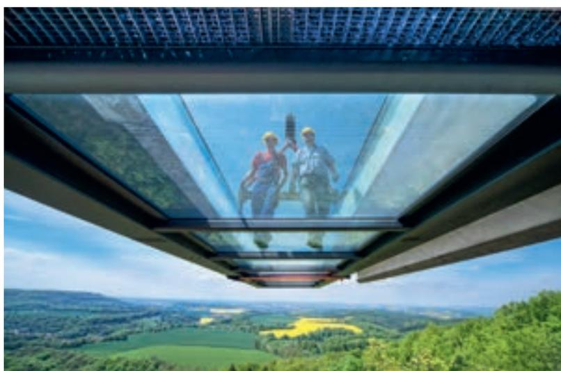
**o.:** Der 14 Meter lange und 13,4 Tonnen schwere Skywalk wurde komplett vormontiert an seinen Standort geliefert und vor Ort auf dem vorbereiteten Sockel verankert.
