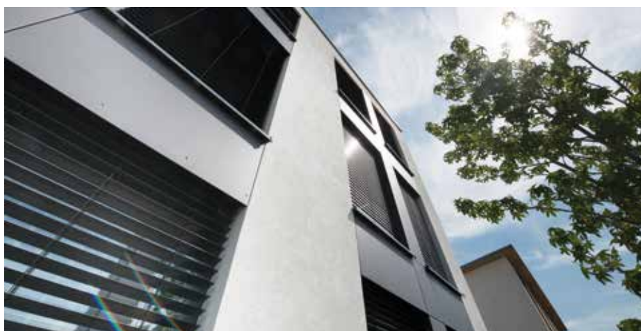
Jede Fassadenseite des Bürogebäudes wird über eine Wetterstation auf dem Dach in Kombination mit der Sonnenschutzzentrale einzeln angesteuert.
