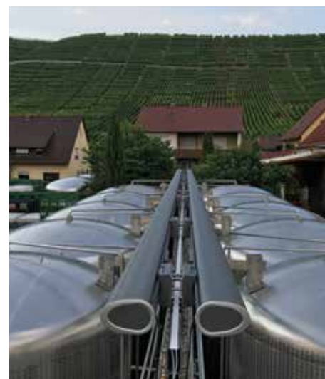
Die Kassetten sind dicht und schützen die Markisen vor der Witterung.
