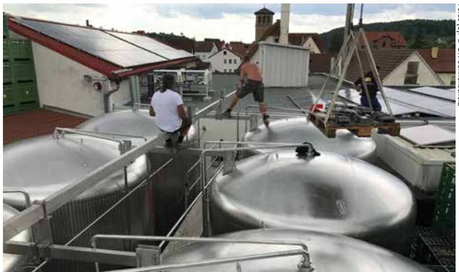
Um die Markisen befestigen zu können, musste zwischen den Tanks ein Stahlgestänge montiert werden.
