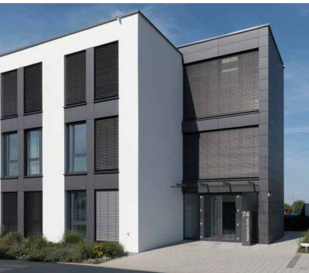
Für die großen Fensterflächen im neuen Bürogebäude der Steuerberaterkanzlei war von Anfang an ein automatisiertes Sonnenschutzsystem eingeplant.
