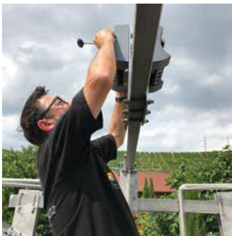
An eine mittig platzierte Traverse werden die Konsolen für die Markisen verschraubt.
