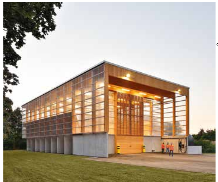
Gewinnerprojekt des Wettbewerbs 2018: Die Salzlagerrhalle der Straßenmeisterei Geislingen an der Steige.
