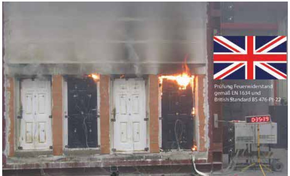
„Im Auftrag Ihrer Majestät“ werden im Rosenheimer Brandschutzzentrum 100 Türen auf Feuerwiderstand gemäß EN 1634 und British Standard BS 476-Pt-22 geprüft.
