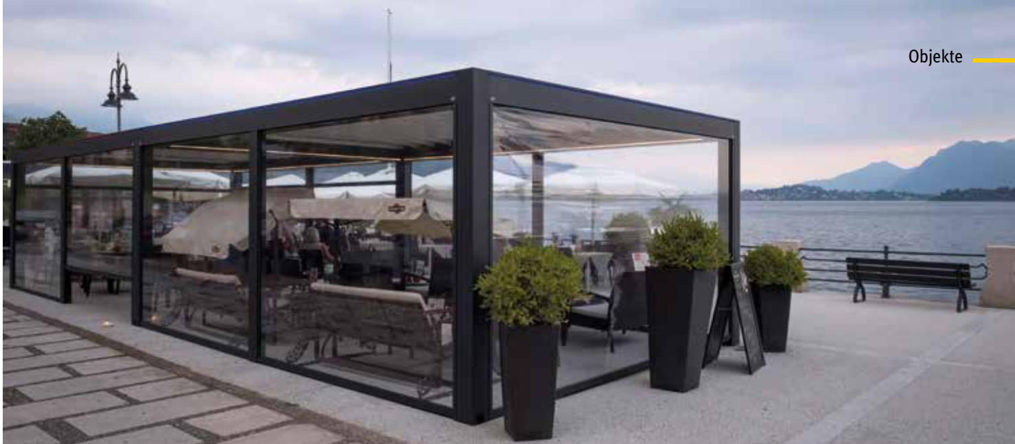
Die Überdachung hat dem Restaurant zusätzliche 106 Quadratmeter überdachte Fläche geschaffen.
