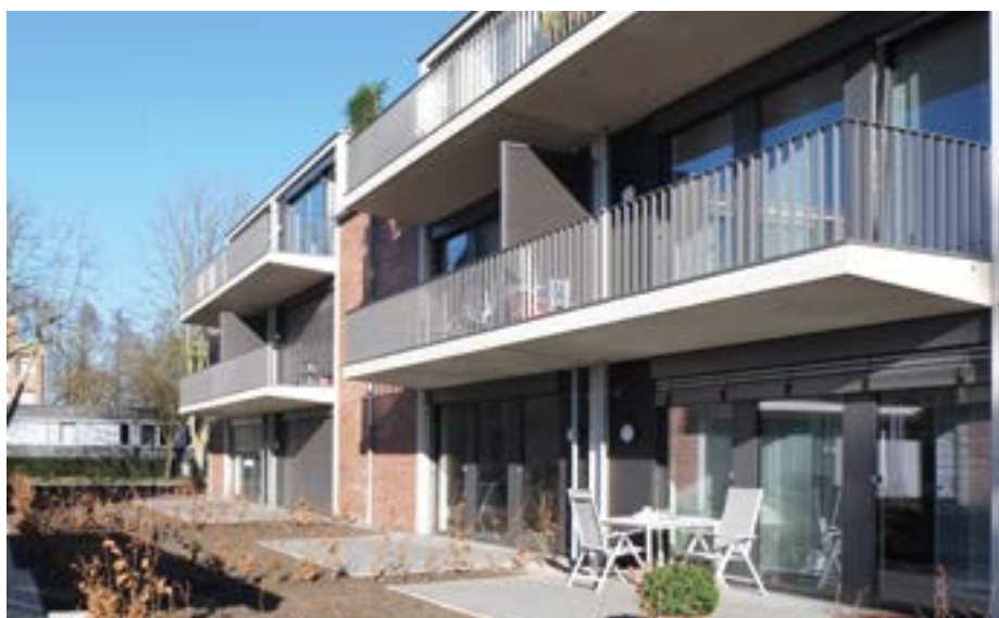
Beim Projekt „Wohnen an der Polizei“ wurden 18 Raffstore-Anlagen montiert.
