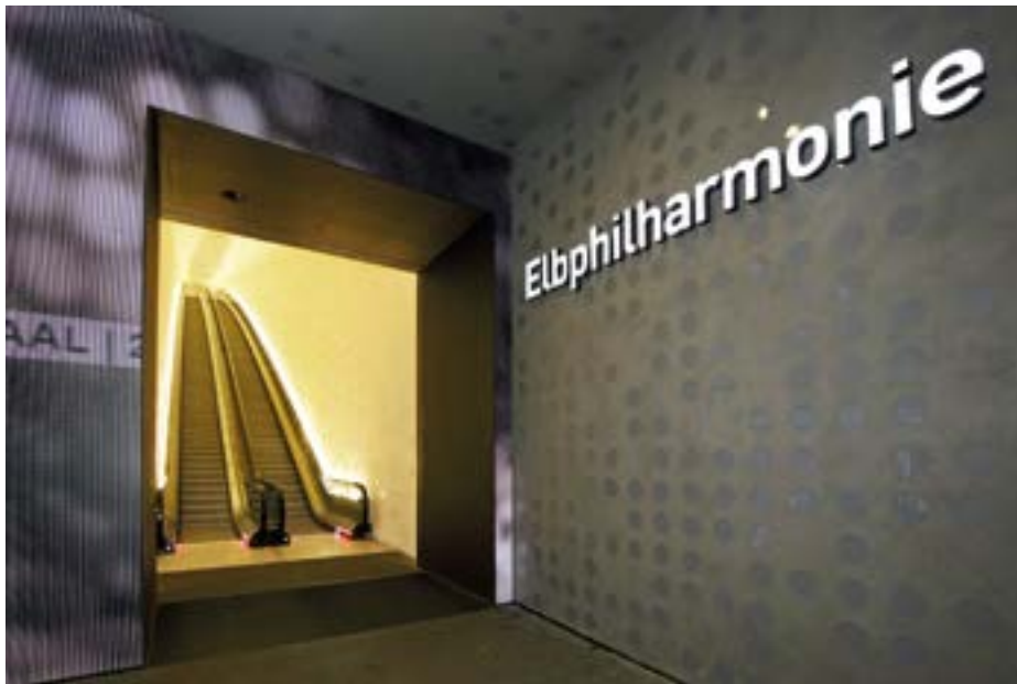
Die Portalverkleidung lässt nur erahnen, dass hier ein Bauelement eingesetzt ist. Technisch ist es mit der Rolltreppe gekoppelt – damit beispielsweise kein Gast von oben losfährt und unten vor verschlossenem Ausgang steht.
