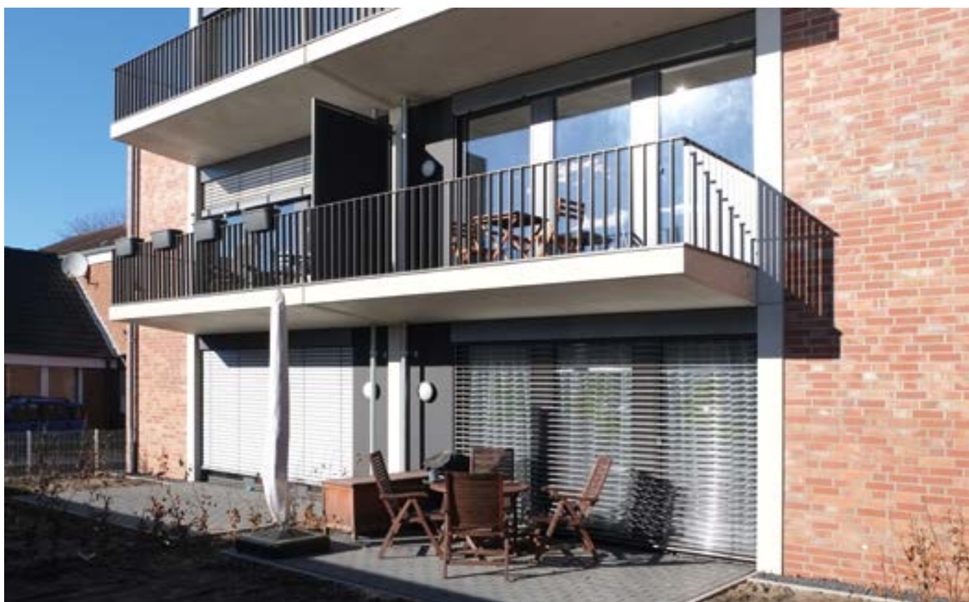
Mit Hilfe eines 230-V-Elektro-Mittelmotors gelingt das Hoch- und Tieffahren der Raffstoren unkompliziert durch die Betätigung eines Schalters. Nahezu jeder beliebige Winkel ist dabei einstellbar, um die ideale Lichteinstrahlung zu erhalten.
