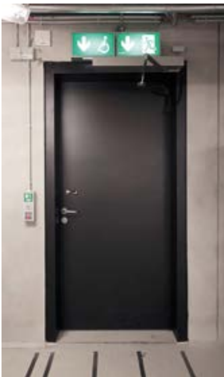
Die Blockzargen sind exakt auf Wandstärke gefertigt und stehen so bündig in der Wandflucht.
