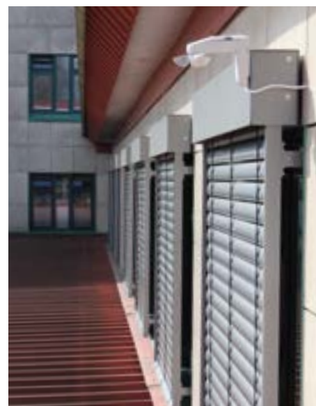
Das Produkt erfasst alle relevanten Wind- sowie Sonnenwerte und fährt in Abhängigkeit daran per Funk den Sonnenschutz. Zugleich werden wichtige Schutzfunktionen der Anlage übernommen.
