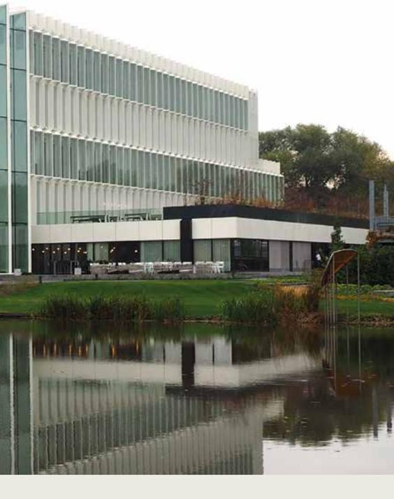
nalene Glaselemente verleiht dem Gebäude eine „geschichtete“ Optik. Um die hohe Energie-Effizienz zu realisieren planten die Architekten hier mit zwei unterschiedlichen Fassadentypen: die Nordfassade einer klassischen hochisolierten Dreifach-Verglasung, alle anderen Seiten mit einer Doppelhaut-
