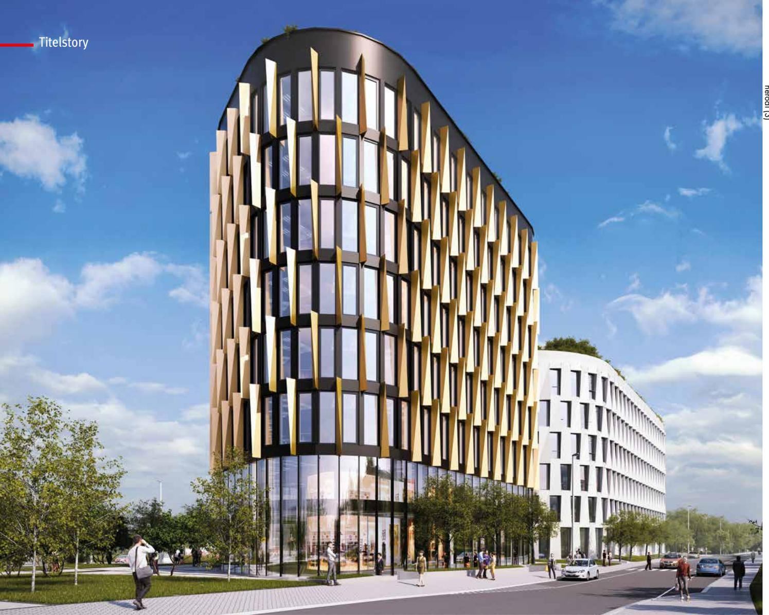
Die schmalen, goldfarbenen Säulen zwischen den Fenstermodulen sind zur Spitze der dreieckigen Grundfläche des Gebäudekomplexes ausgerichtet.
