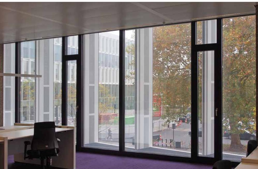
Zwischen wärmegeprägten Innen- und der „kalten“ Außenhaut liegt ein auf Rosten begehbare Innenraum, von dem aus Fenster geputzt und Wartungsarbeiten durchgeführt werden können.
