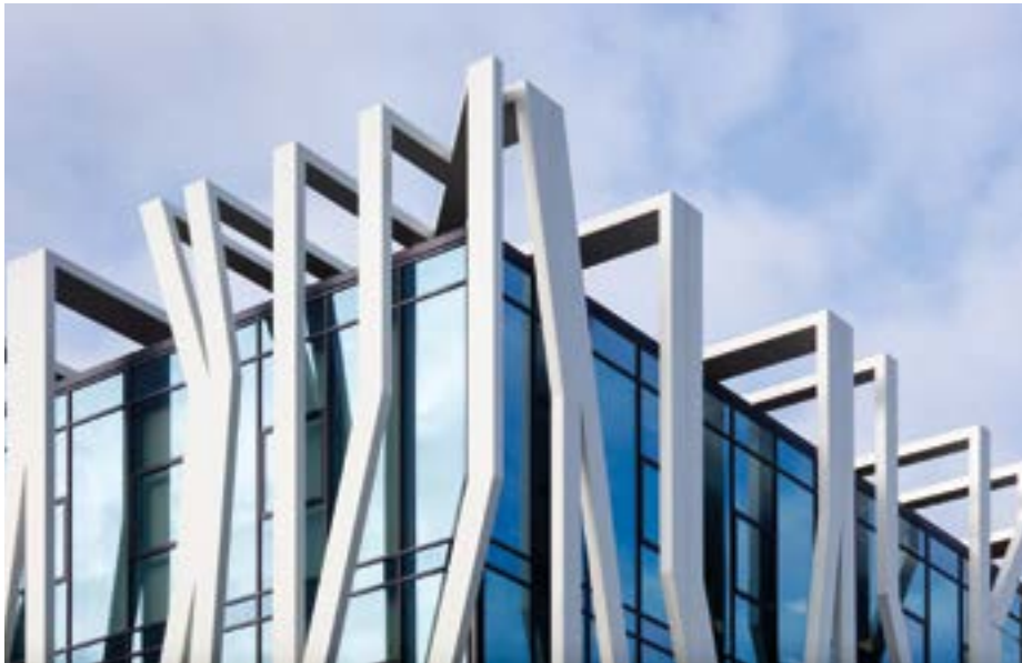
Das gesamte Glasgebäude wurde mit ca. 3000 Quadratmetern Dreifach-Sonnenschutzisoliervlas ausgestattet.
