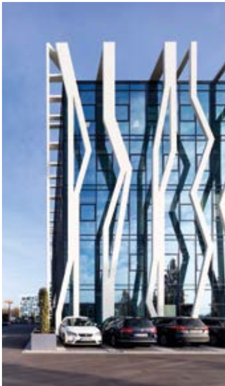
Die hohe Flexibilität durch veränderbare Raumstrukturen berücksichtigt auch die gerasterte Fensterfassade.
