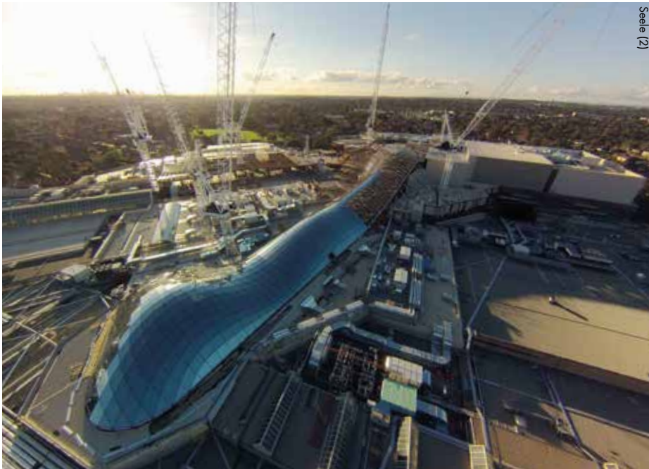
Herausforderung für die Logistik: Jeweils fertige Bauabschnitte wurden in Etappen verglast.
