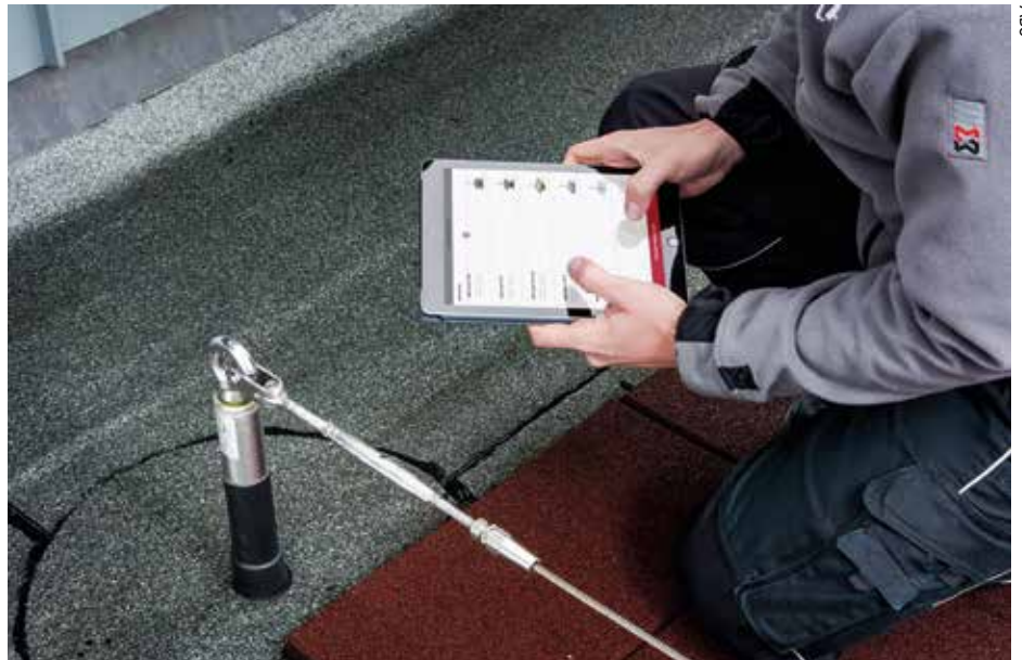
Mit der neuen App wird die Montage vor Ort digital dokumentiert und gespeichert.
