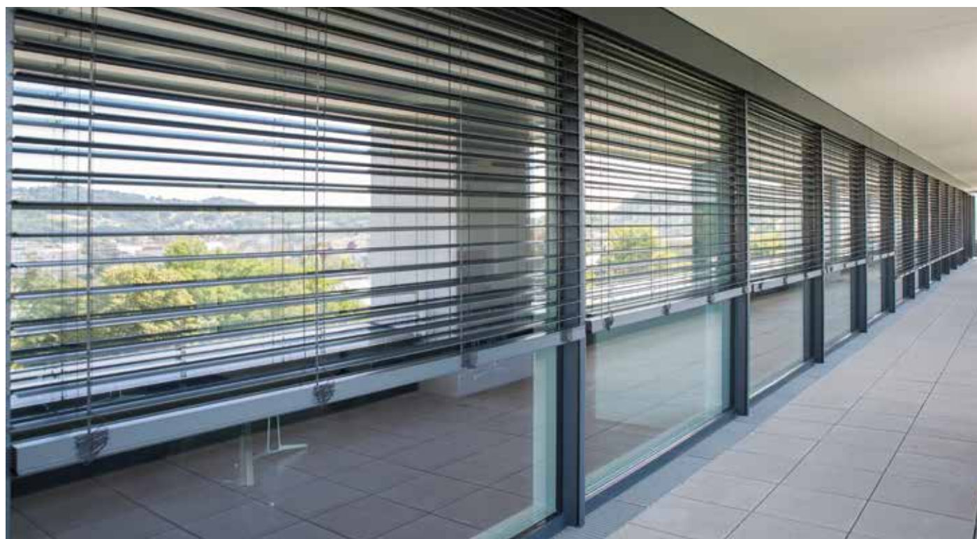
800 Klick-Raffsysteme reflektieren im Sommer die Strahlung bereits außen an der Fassade und halten sie so von der Scheibe ab.
