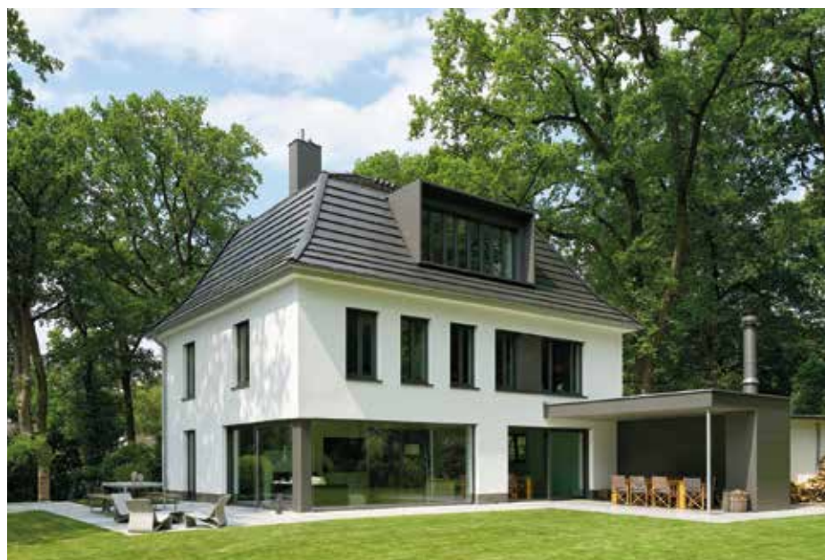
Durch sorgfältige Planung bei Größe, Feldaufteilung und Positionierung der Lichtöffnungen konnte der ursprüngliche Charakter des Gebäudes erhalten werden.
