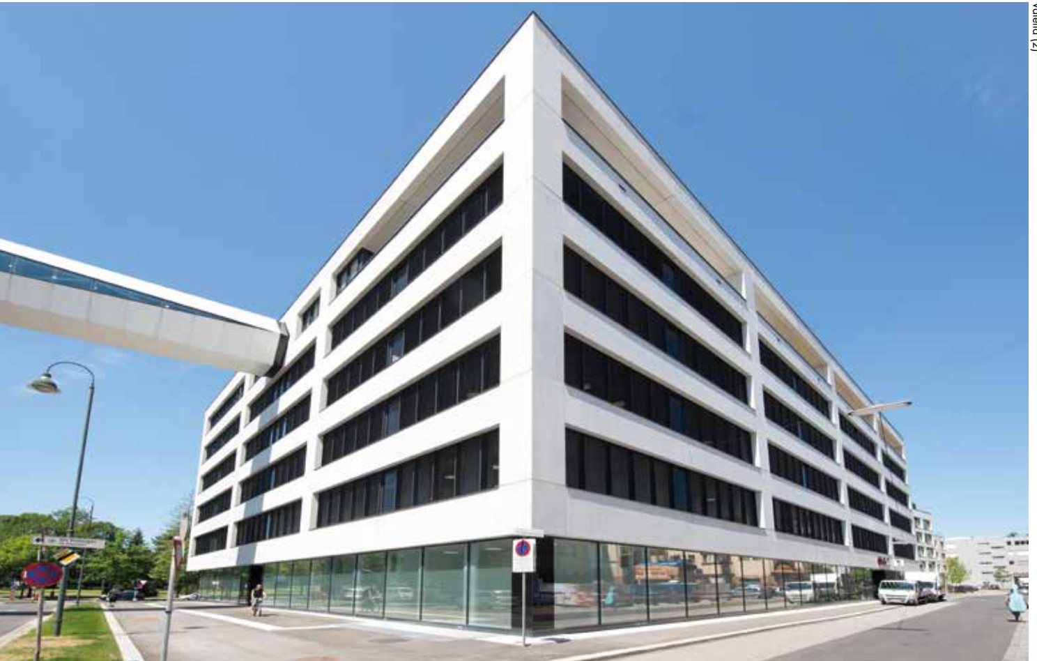
In der neuen Firmenzentrale der Oberbank AG in Linz unterstützen Sonnenschutzsysteme die positive Energiebilanz und den visuellen Komfort.
