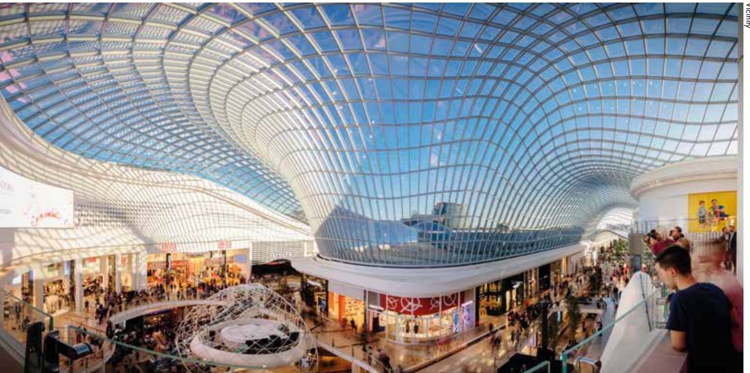
Das Chadstone Shopping Center in Melbourne hat ein beeindruckendes, freitragendes Glasdach erhalten.
