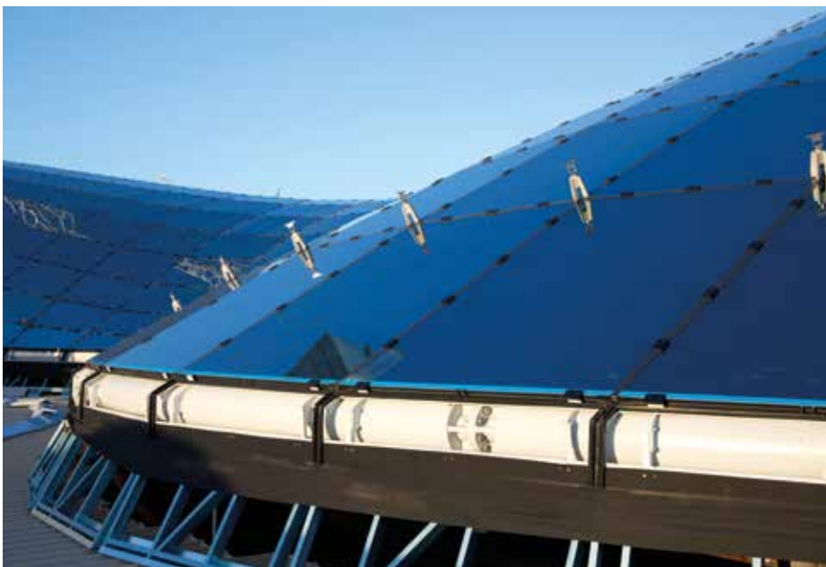
Bei der sehr anspruchsvollen Scheibengeometrie sorgt der Randverbund für eine dauerhaft dichte Warme Kante.
