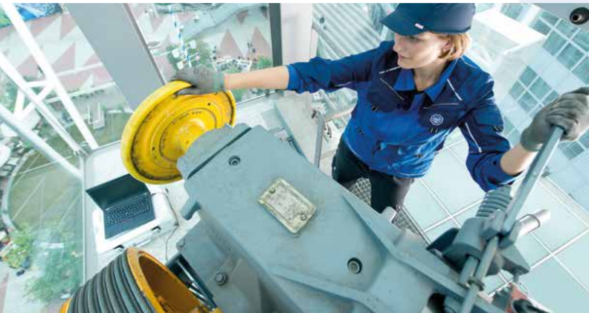
Prüfung der Treibfähigkeit / Checking traction capacity
