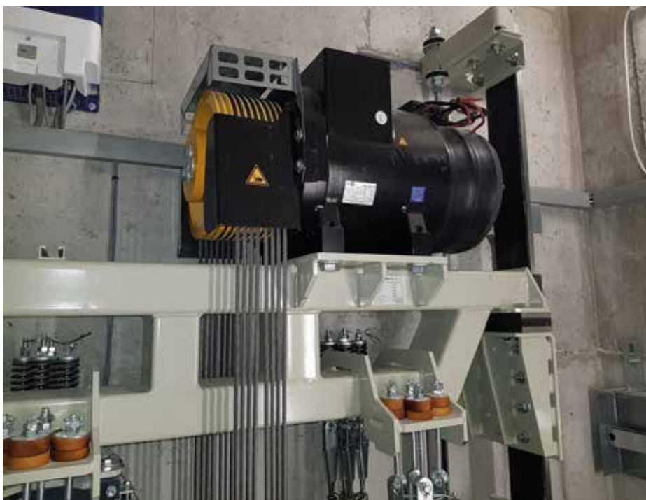
Triebwerksrahmen für Aufzug ohne Triebwerksraum / Drive frame for lift without machine room
