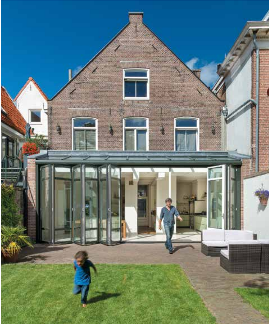
Die Außenwände und die Geschosdecke des Backsteinbaus wurden verlängert und das Gebäude mit einem gläsernen Wintergardendach ergänzt.
