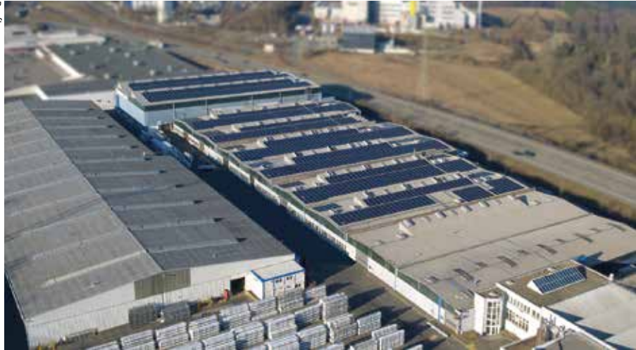
Für die EEG-konforme Photovoltaikanlage wurden auf insgesamt fünf Dächern der Werkshallen insgesamt 4583 Module verbaut.
