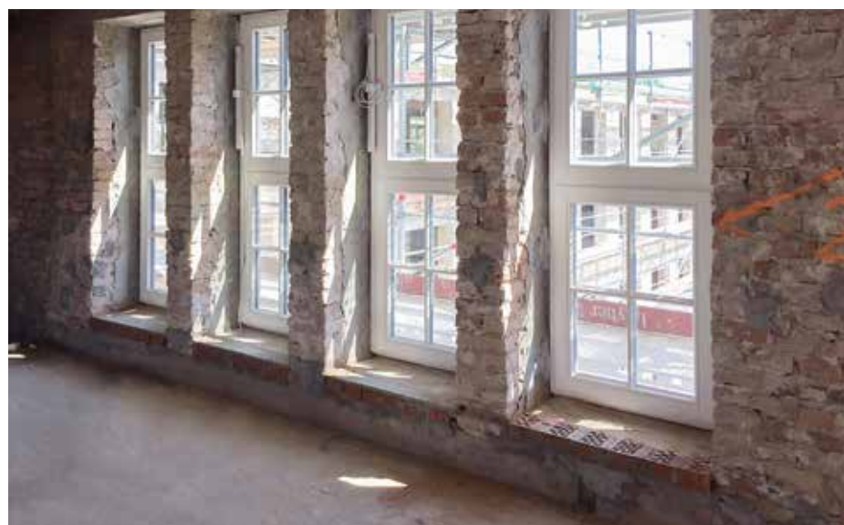
Die Montage der ersten Treppenhausfenster ist bereits erfolgt.
