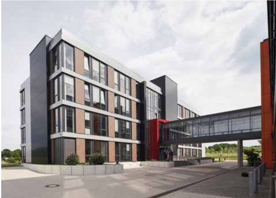
Die Anbindung an den Campus erfolgt über eine Glasbrücke im 1. Obergeschoss. Die signalrote Farbe des Windfangs leitet die Besucher ins Gebäude.
