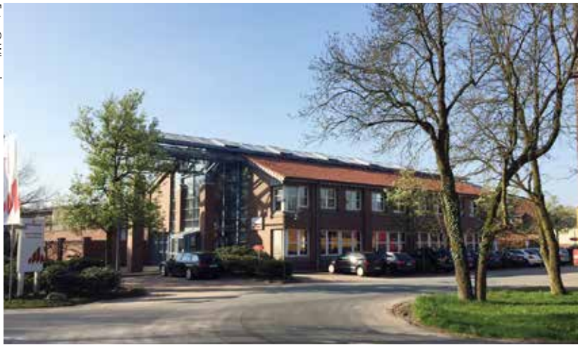
Das Wienerberger Werk in Kirchkimmen wird umgebaut.
