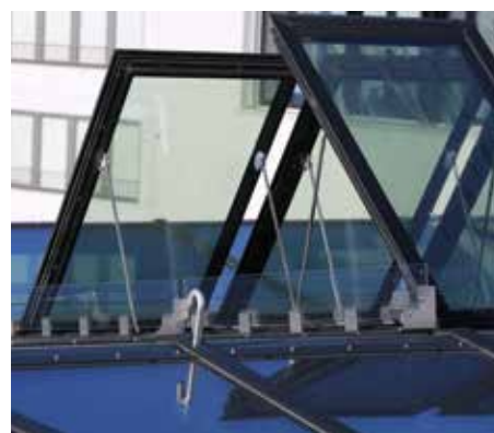
Die Rauchabzugsöffnung im Dach der HafenCity Universität Hamburg.
