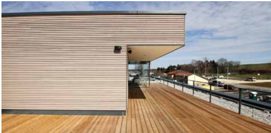
Die Holzterrassen auf dem Flachdach.
