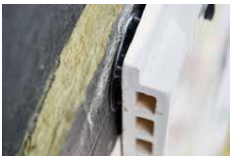
Drei Komponenten gehören zum „Fixrock BWM Brandriegel Kit“: 1. eine feste Dämmung und 2. eine weiche Dämmung, die miteinander verklebt, fertig konfektioniert in verschiedenen Dicken an die Baustelle geliefert werden und 3. spezielle Abstandhalter aus Kunststoff.
