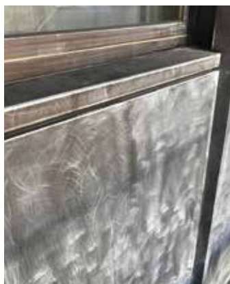
Bild 4: Die eloxierte Oberfläche wurde zur Haftungsverbesserung und Schmutzbeseitigung angeschliffen.
