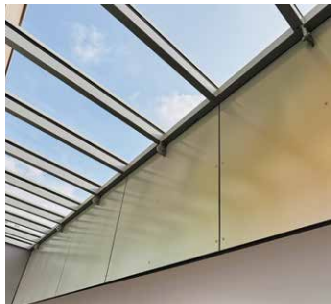
Die Rockpanel Chameleon Platten verändern durch eine Kristalleffektschicht auf der Oberfläche je nach Betrachtungsperspektive und Einfall des Sonnenlichts ihre Farbe.
