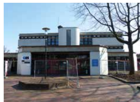
Schrödervermiring architekten, ingenieure
