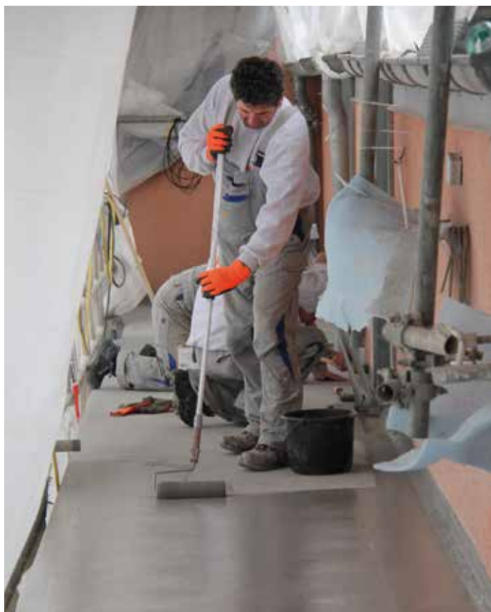
Fachgerecht beschichtet: Flammhemmende Abdichtung mit Flüssigkunststoff.
