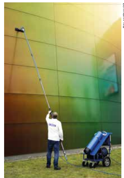
Effektiv und schnell: Fassadenreinigung mit Reinwasser-Technologie.
