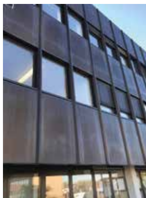
Bild 1: Ausgangszustand der Fassade.
