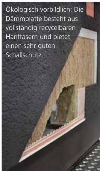
Ökologisch vorbildlich: Die Dämmplatte besteht aus vollständig recycelbaren Hanffasern und bietet einen sehr guten Schallschutz.
