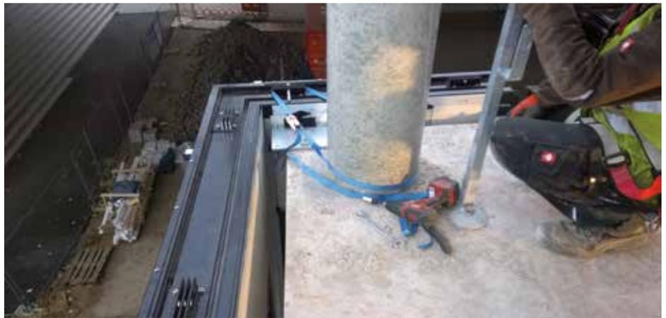
Verankerung zur Abhängung einer Elementfassade im Eckbereich (durch eine Elementfassade können Rohbauverformungen besser aufgenommen werden).
