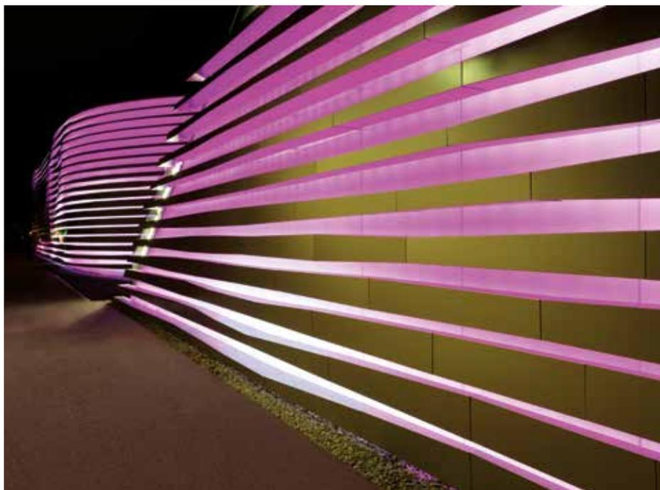
Highlight bei Nacht: Für das Projekt wurde eine aus 6500 einzeln ansteuerbaren Lichtpunkten bestehende Medienfassade entwickelt.
