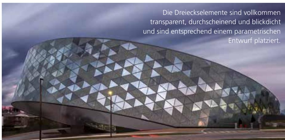
Die Dreieckselemente sind vollkommen transparent, durchscheinend und blickdicht und sind entsprechend einem parametrischen Entwurf platziert.
