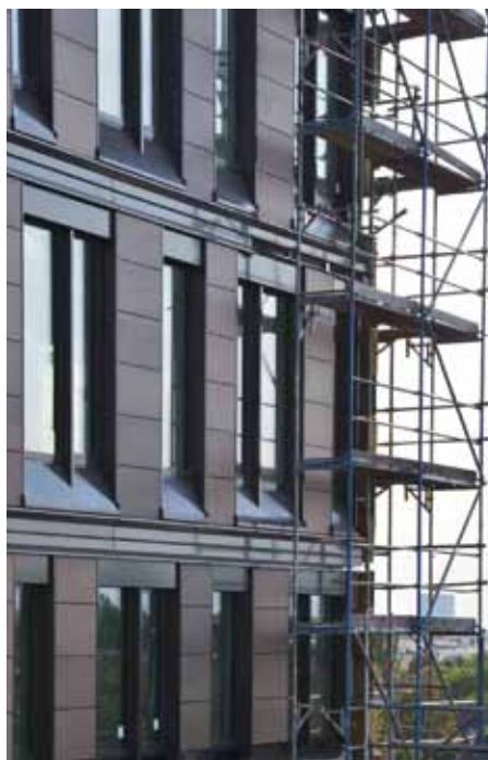
Die Keramikfassade während der Bauphase.
