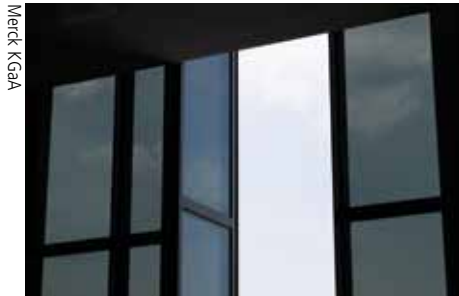
Die schaltbare Flüssigkristallfenster-Technologie in der Anwendung.
