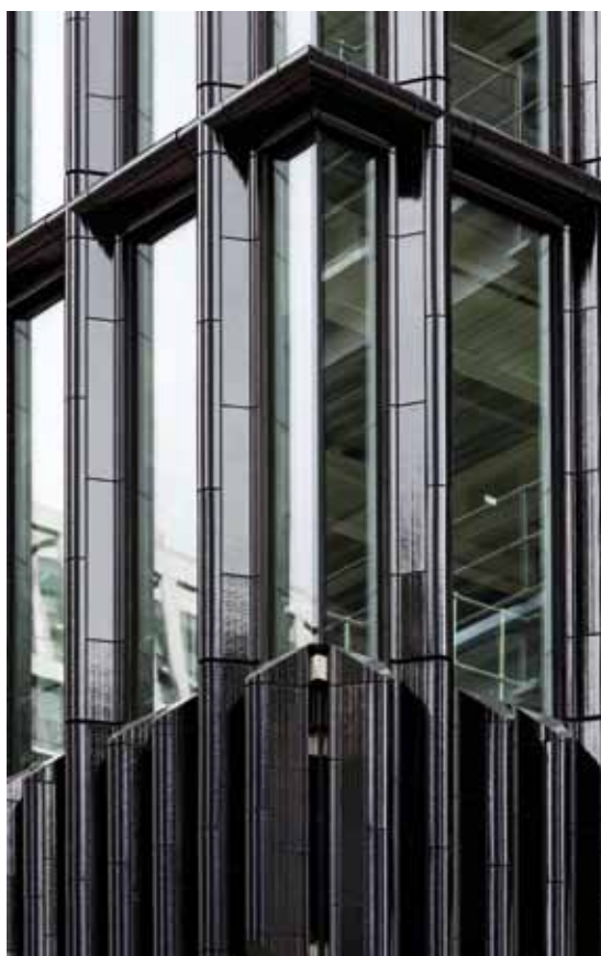
Die glänzende Keramikfassade am London Wall Place: hier eine Ecklösung.
