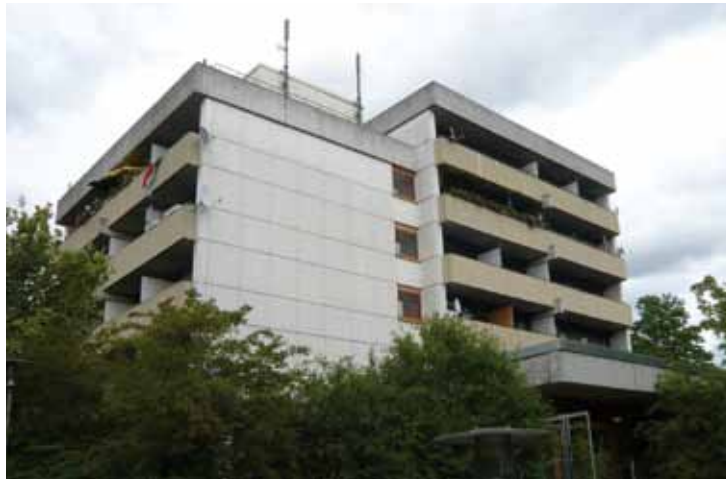
Ursprungsgestalt des 70er-Jahre Baus des ehemaligen Schwesternwohnheims in Waiblingen. Sto SE & Co. KGaA
