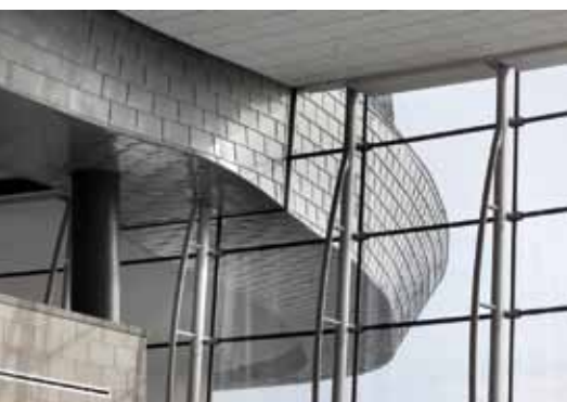
Kontrastreiches Zusammenspiel zwischen Stahlkonstruktion und Titanzink-Fassade.
