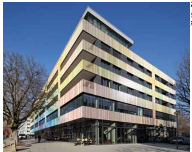
Die mit 47 verschiedenen Duraflon-Tönen beschichteten Lamellenbänder legen sich fast wie eine textile Hülle um das Gebäude am Neckarufer.
