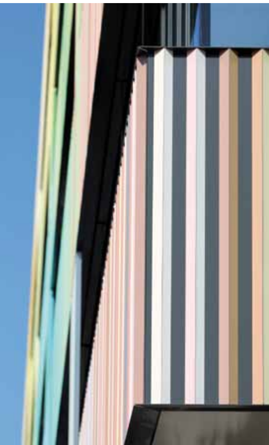
Die gerippte Struktur basiert auf Aluminiumprofilen mit dreieckigem Querschnitt.
