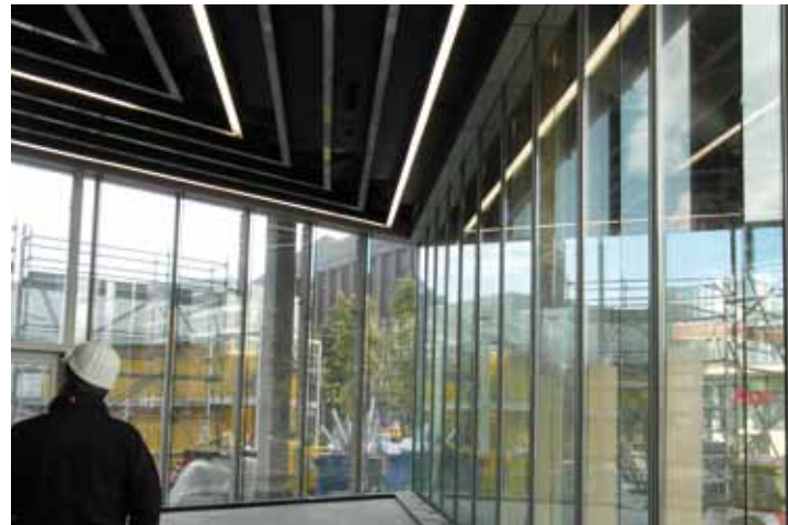
Das Ergebnis der Sanierung ist eine architektonisch anspruchsvolle Fassade.
