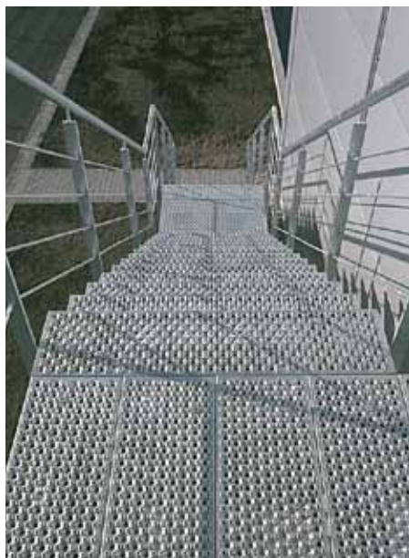
Die DASSt-Richtlinie 022 ist auch für leichte tragende Stahlkonstruktionen wie Treppen, Balkone, Geländer verbindlich anzuwenden.
