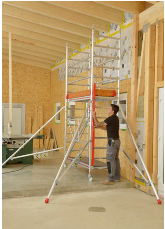
So ist es richtig: Das Fahrgerüst ist lotrecht aufgebaut. Der Anwender kann das Gerüst gefahrlos betreten, sicher stehen und arbeiten.
