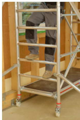
So ist es richtig: Festes Schuhwerk beim Besteigen eines Gerüsts ist Pflicht!
