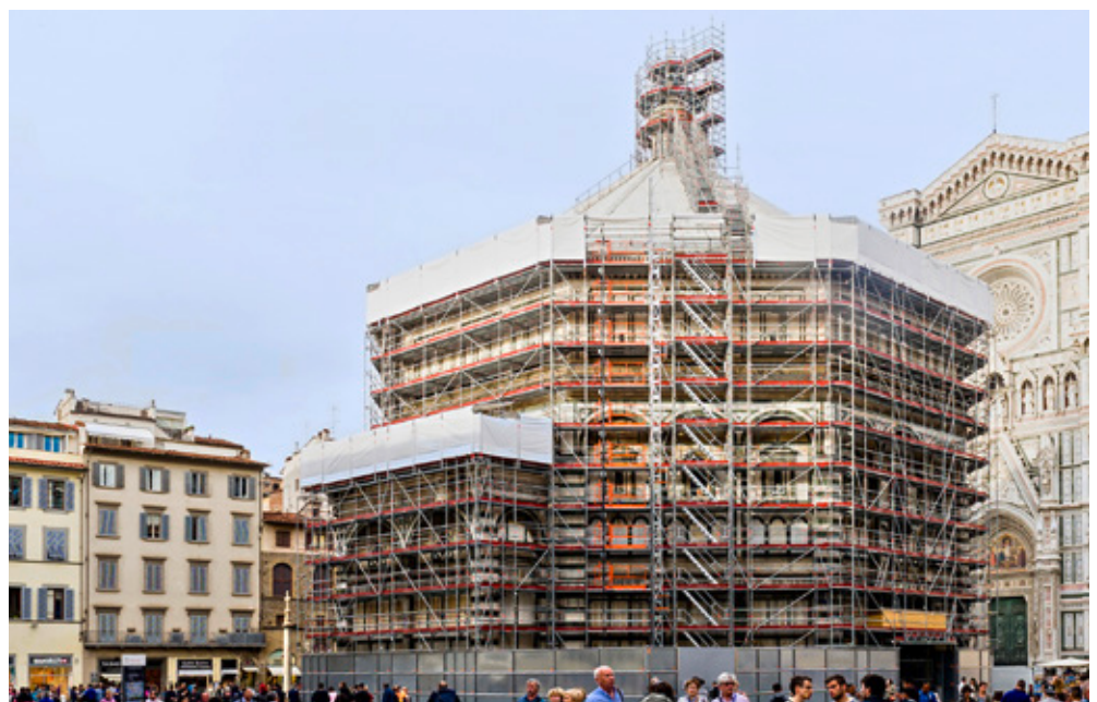
Mit Konsolen aus dem Allround-Baukasten konnten Gerüstbauer das Arbeitsgerüst zur Sanierung des Baptisterium San Giovanni schnell und sicher an die Gebäudegeometrie anpassen Foto: Layher
