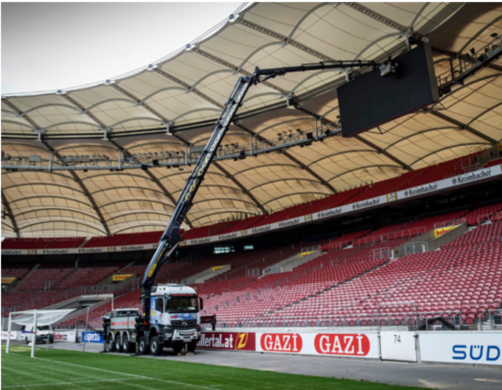
Wartung der LED-Anzeigetafel in der Mercedes-Benz-Arena
