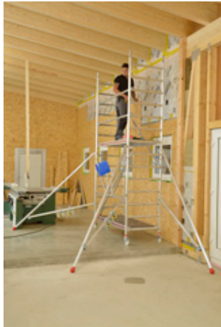
So ist es falsch: Fehlen die Bordbretter rund um die Belagfläche, kann Werkzeug oder Material ungesichert herunterfallen.
