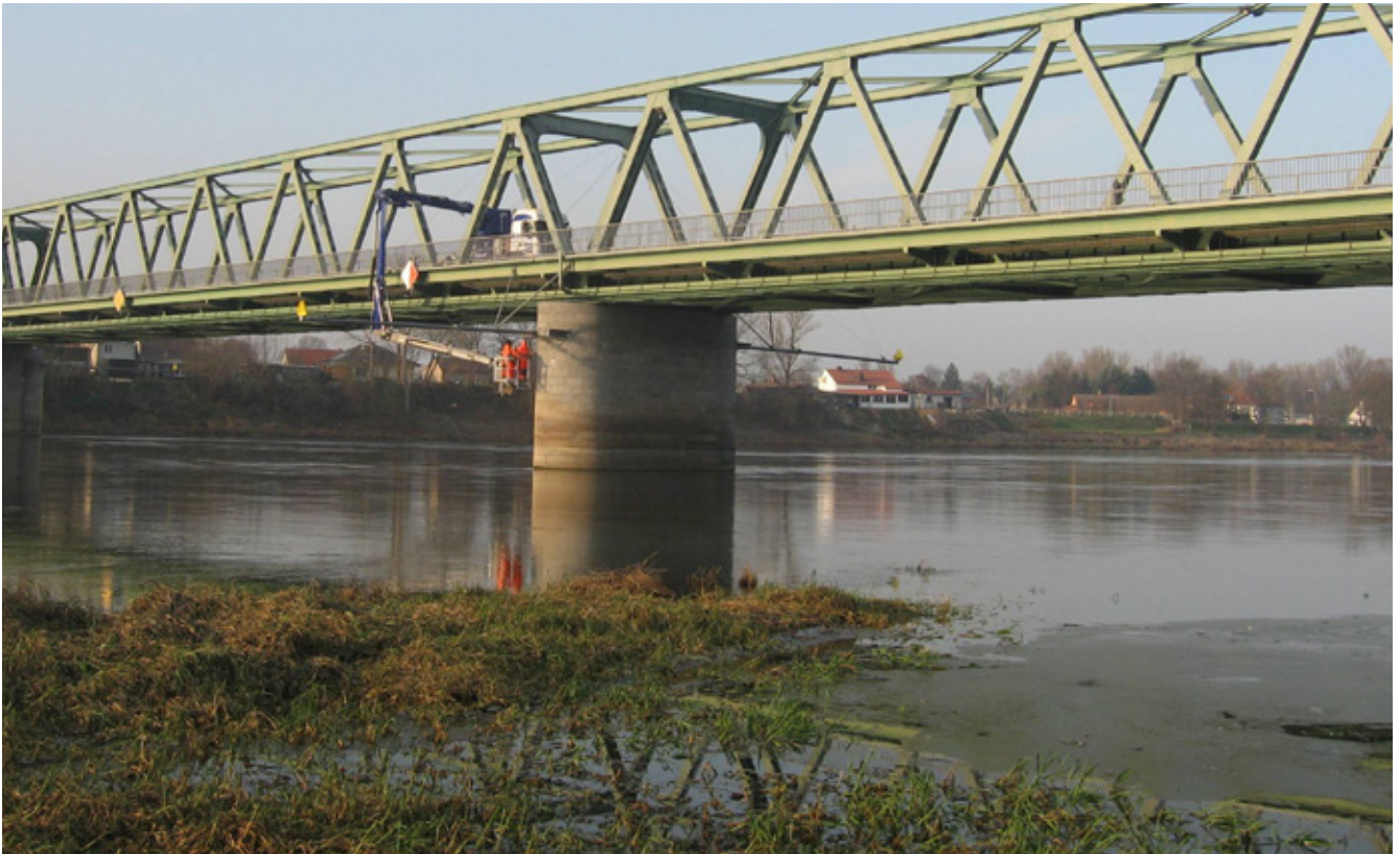
Das Brückenuntersichtsgerät MBL 1750T beim Einsatz an der deutsch-polnischen Brücke in Hohenwutzen
