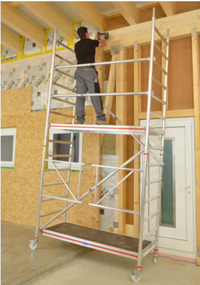
So ist es falsch: Wenn das Fahrgerüst schräg steht, hat das Gerüst – und somit auch der Anwender – keinen stabilen Stand.
