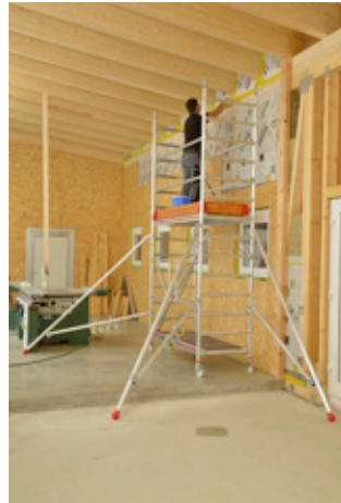
So ist es richtig: Erst nach der vorgeschriebenen Absicherung der Belagfläche mit Bordbrettern an allen vier Seiten ist der vorgeschriebene Seitenschutz gewährleistet. Das Gerüst ist einsatzbereit.
