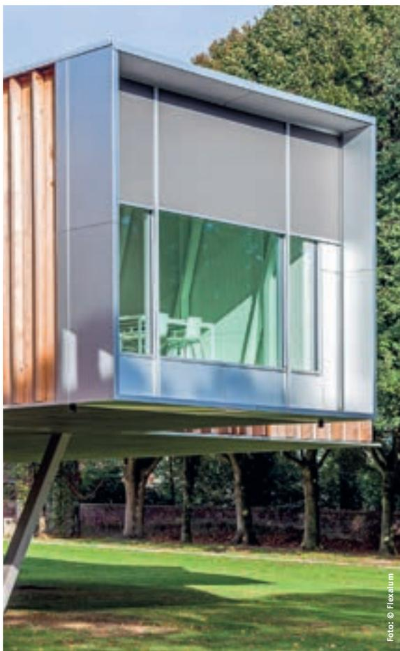
Der SmartScreen ZIP ist in Behangbreiten oder -höhen von bis zu sechs Metern verfügbar und weist dank ZIP-Technologie eine optimale Tuchspannung auf.
